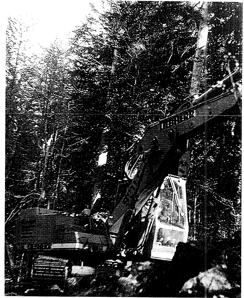
Primjenom novih radnih postupaka pri gradnji traktorskih vlakova uz upotrebu jaružala (bagera) s hidrauličnim čekićem za razbijanje stijena znatno je smanjeno oštećivanje stabala i naprezanje radnika, a proizvodnost radnika povećana.
